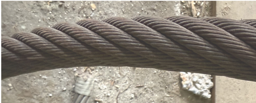
Bild 8.1: Seilabschnitt ohne erkennbare Schäden
